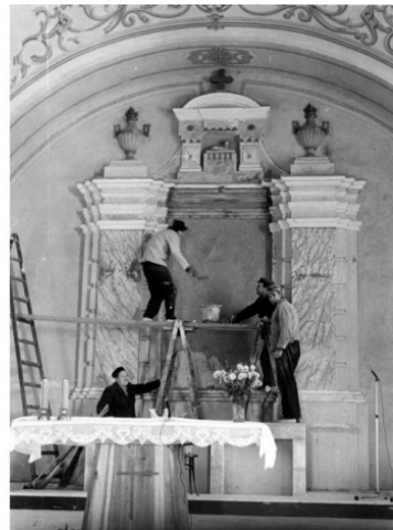
Rekonštrukcia hlavného oltára
