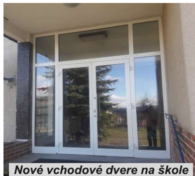
Nové vchodové dvere na škole
